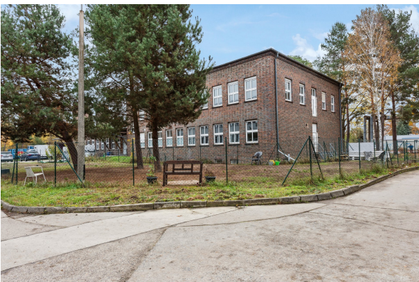
Gebäudeansicht von hinten
