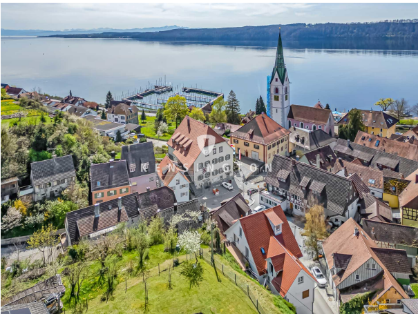
Lenzensteig 4 (Nord- und Westseite)
